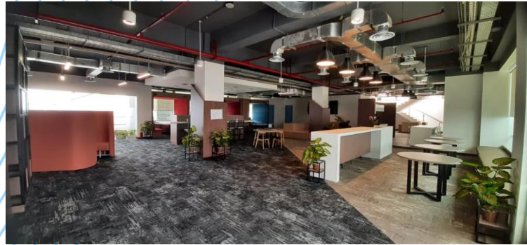
Gambar 56. Renovasi Gedung D lantai 7
