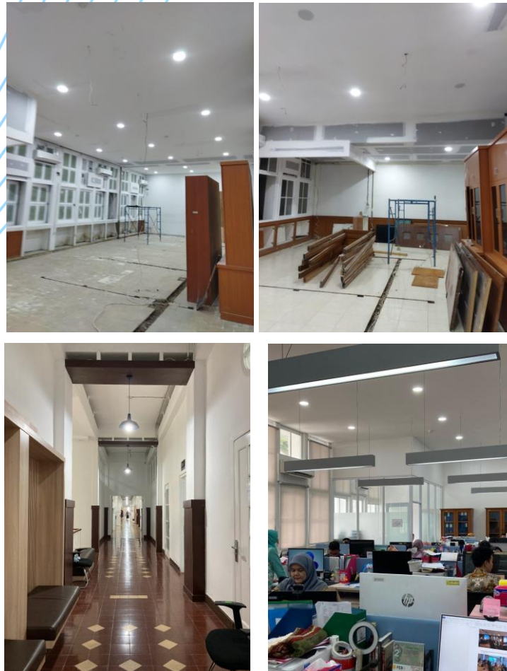
Gambar 60. Kegiatan Renovasi dan Interior Gedung F
